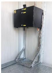
Réservoir diesel à double paroi installé séparément de la motopompe sur un support spécial en acier galvanisé et déjà relié au moteur diesel.
