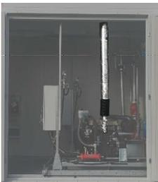
Conduit d'évacuation des fumées convenablement isolé et acheminé vers l'extérieur, avec fermeture par gravité.
